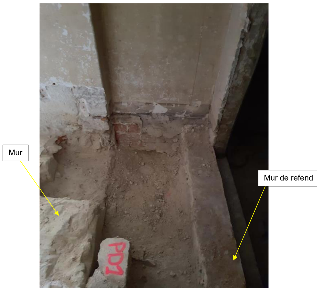
Photo de la fouille de reconnaissance RFI INFRANEO
