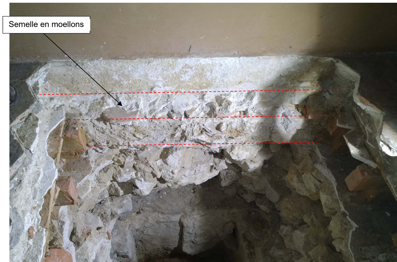
Vue de la fondation du pan de bois – fouille RF1
