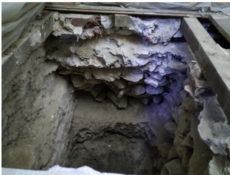
Remplissage de blocs au droit de la fouille RF2
